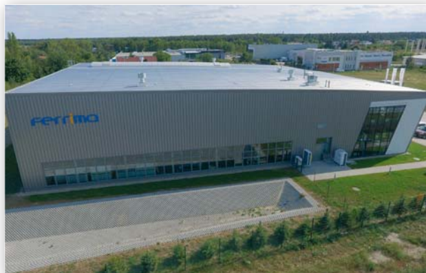
Budynek biurowy Ferrima Bogucin, Polska. 500 m 2
