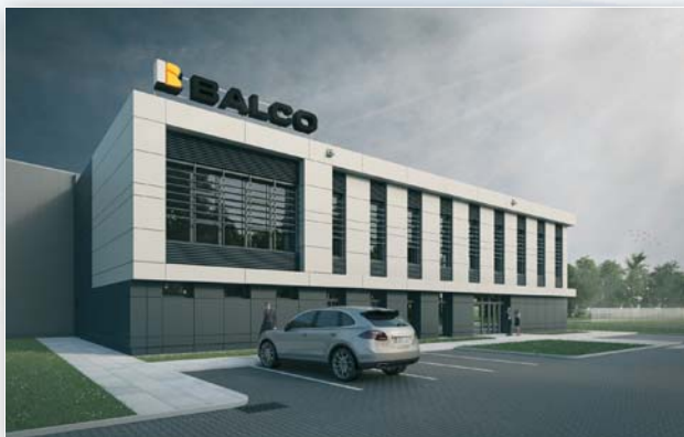
Balco - fabryka Łowry / Międzychód, Polska. 4 000 m 2
