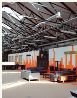
Rozwiązanie wybrane przez firmę ZALANDO na potrzeby konwersji powierzchni magazynowej na biuro. Grand Canal Quay, Dublin. ECOi
