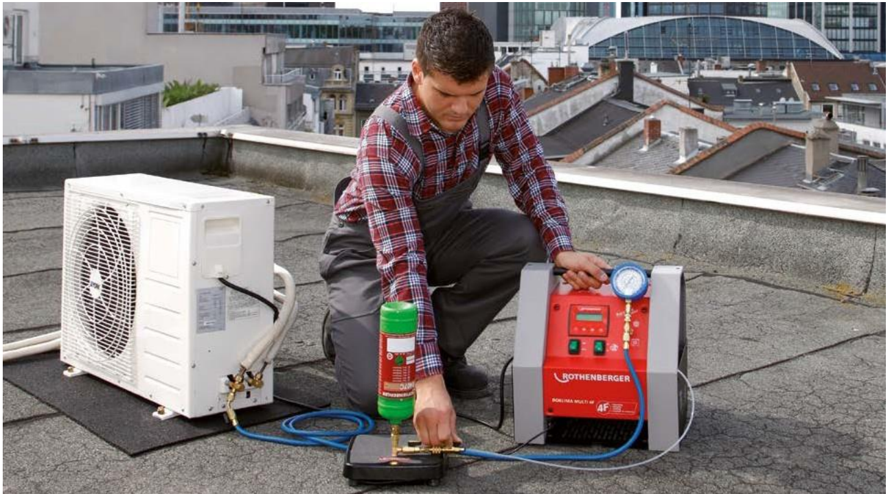
ROKLIMA MULTI 4F w użyciu (usuwanie i ładowanie czynnika)
