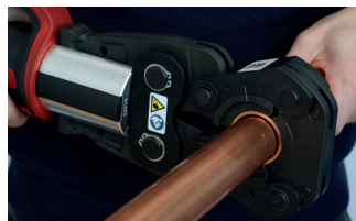
3. Zaprasuj połączenie
